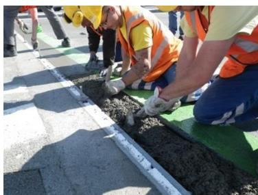
Mise en œuvre du mortier
