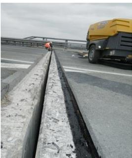
Nettoyage du vide entre le tablier et le garde grève, et préparation du support
