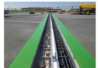
Pose des rails du joint en vue du bétonnage (réglage et fixation)
