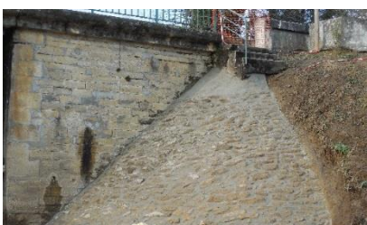
Réfection des perrés de l'ouvrage
