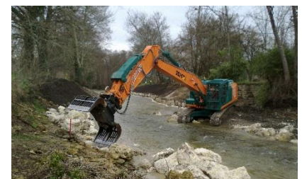
Enrochement des berges
