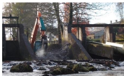
Démolition du barrage existant
