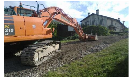
Création de la piste d'accès
