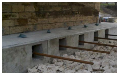
Mise en œuvre des tirants
