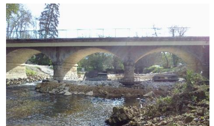
Création du batardeau
