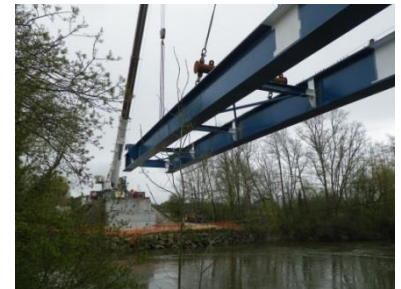
Grutage de la charpente métallique
