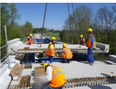
Pose et clavetage des dalles préfabriquées
