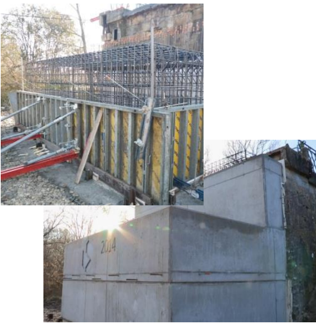
Construction de la nouvelle culée
