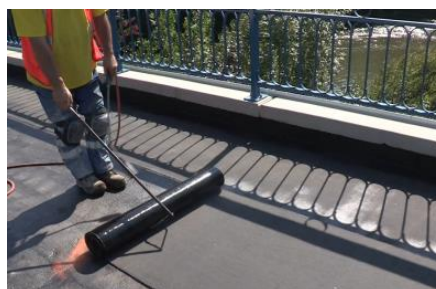
Etanchéité du tablier
