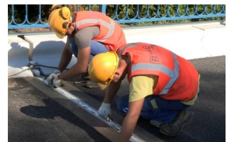
Pose des joints de chaussée
