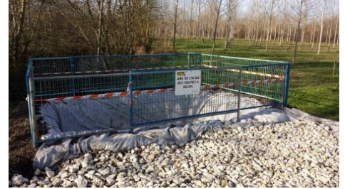
Aire de lavage des toupies à béton
