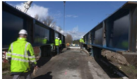
Montage de la charpente métallique
