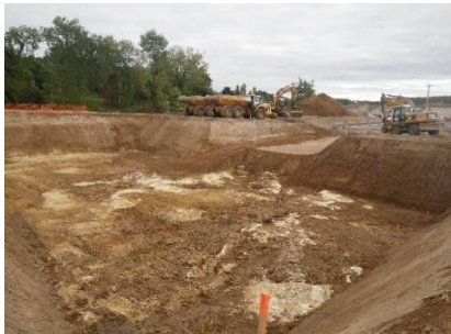
Réalisation de l'aire de préfabrication
