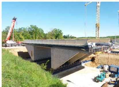
Vue d'ensemble de l'ouvrage préfabriqué avant ripage
