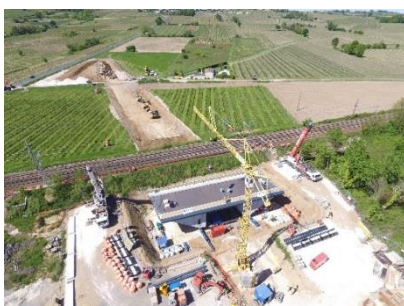
Vue d'ensemble du chantier avant OCP
