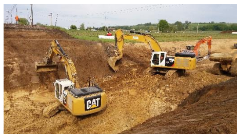
OCP : Terrassements après dépose de la voie
