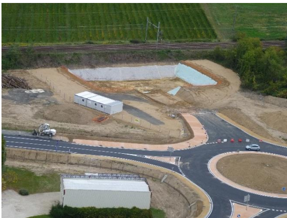
VUE DU SITE APRES REALISATION DE L'AIRE DE PREFABRICATION
