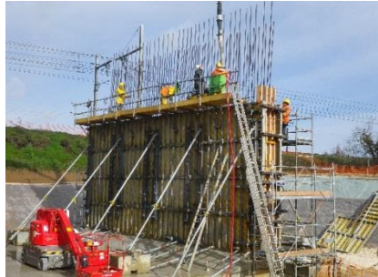
Bétonnage d'un piédroit
