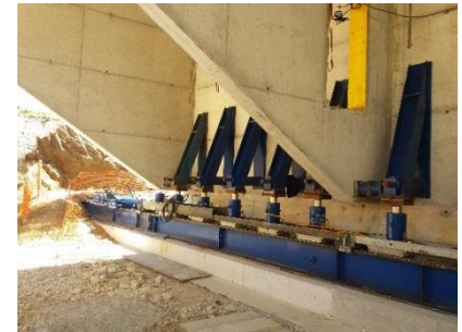
Chemin de ripage + Consoles
